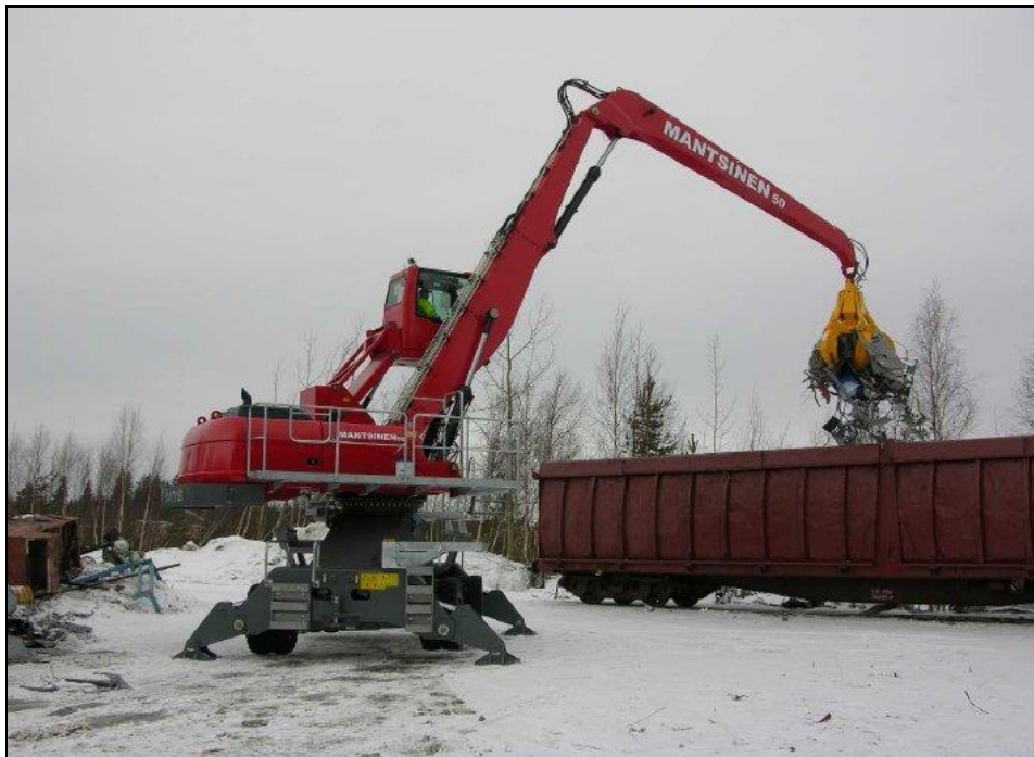
Figure 27 : Exemple de grue mobile avec grappin
